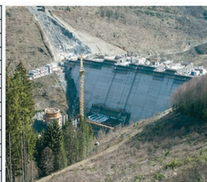
Bild 1: Talsperre Leibis/Lichte: Kenndaten und Bild der Staumauer im Bau (Mai 2004)
