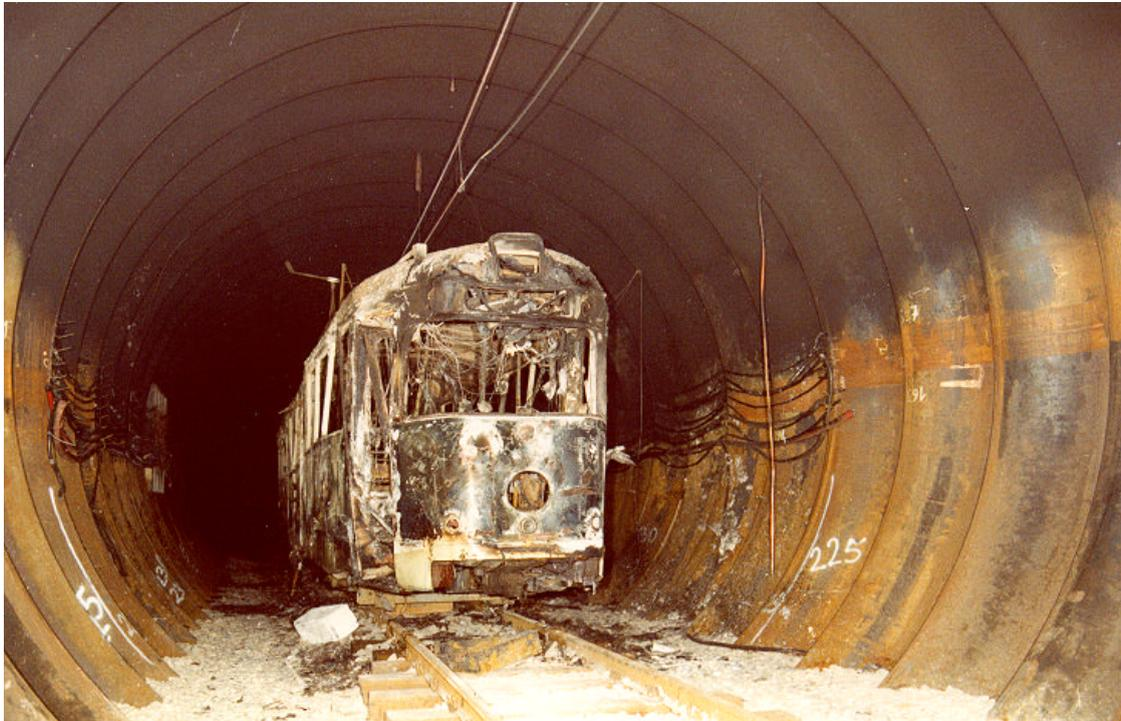
Bild 8: In-situ-Brandversuch eines Strassenbahnwagens, durchgeführt durch DMT
