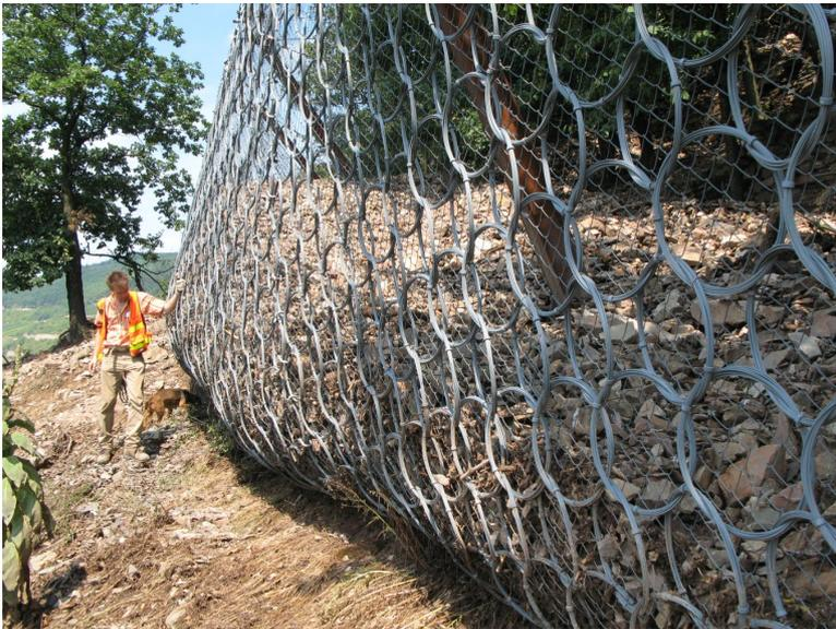
Bild 3: Fangzaun nach einem Murenabgang
